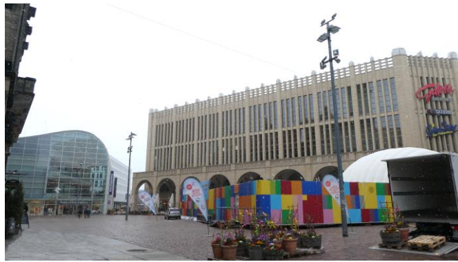
Gläsernes Kaufhaus und Galerie Roter Turm
